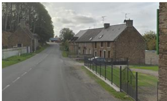
Forme d'implantation des constructions de la zone à l'image des implantations traditionnelles = parallèle au coteaux et en limites séparatives.
