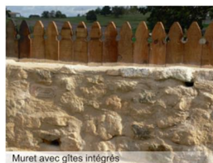
Aménagements d'ouvertures en pied de clôture (avec hérisson décoratif) et de muret
